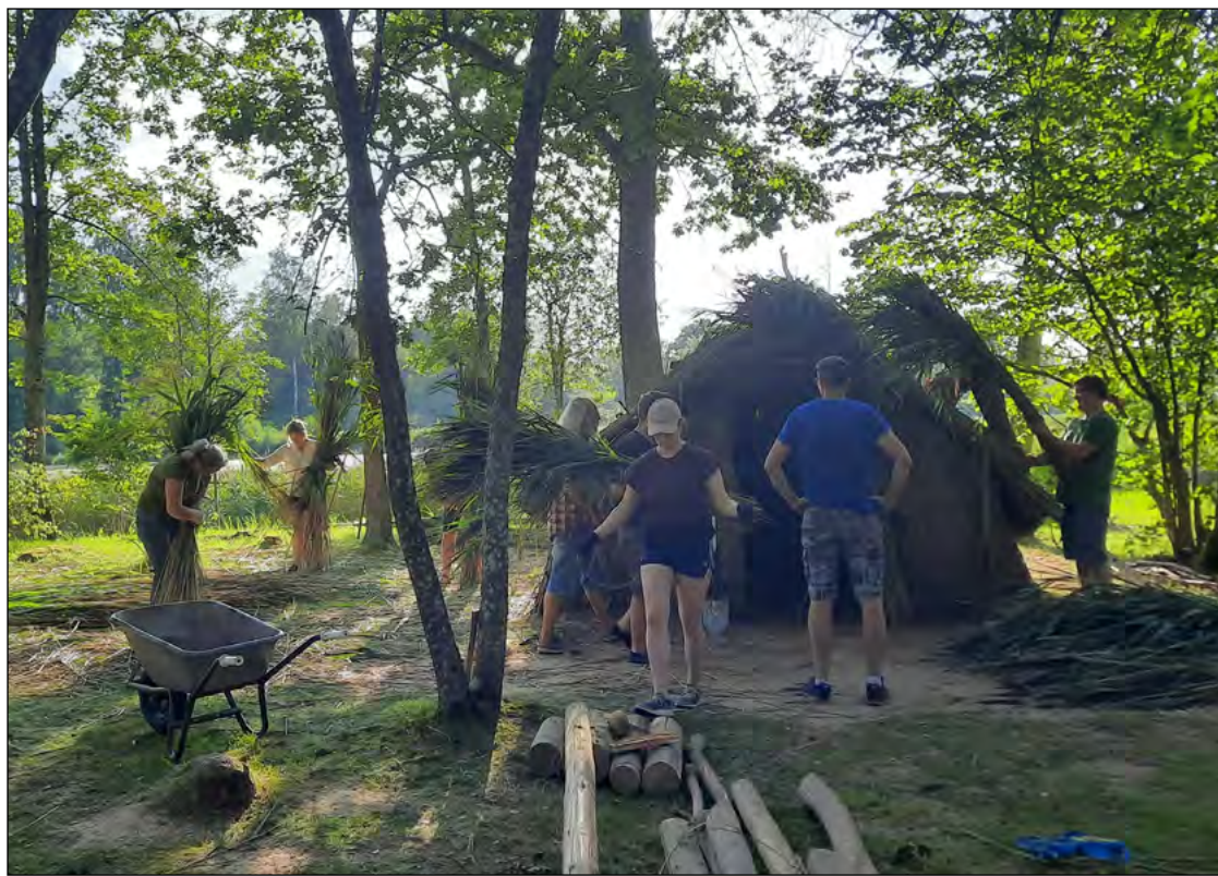
Akmens laikmeta mājokļa atjaunošana – niedru kūlišu siešana un jumta ieklāšana. Foto: Eva Koljera
