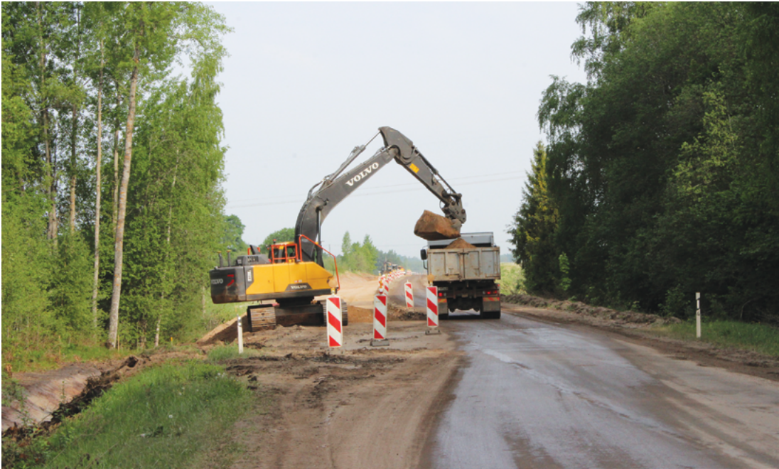
Attēlā: Stalbes ceļa remontdarbu vietās darbojas četri luksofori, un jārēķinās, ka brauciens var ieilgt par 10-15 minūtēm. Foto Aivars Akmentiņš.
