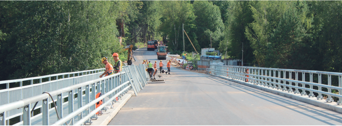
Attēlā: Rāmnieku tilta būvdarbi, atbilstoši plānotajam, tuvojas noslēgumam un šajā ceļa posmā drīz jau varēs atjaunot satiksmi. Foto: Aivars Akmentiņš.
