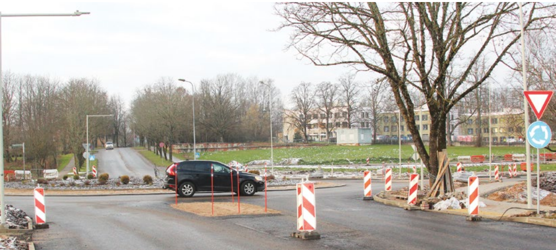
Attēlā: Rotācijas apli ieklāta pirmā asfalta kārtā, un vēl turpinās ietvju izbūve ap krustojumu. Foto: Aivars Akmentiņš.
