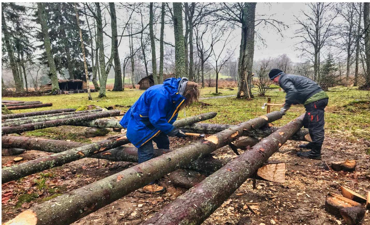
Eksperimentālās ēkas būvniecība 2021.gada novembrī.
